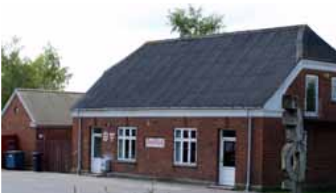
Den gamle stationsbygning i Sejffjord - nu bruges bygningen af spejder.
